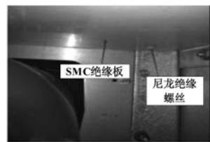
图 12 金属中隔板下部加装绝缘板
